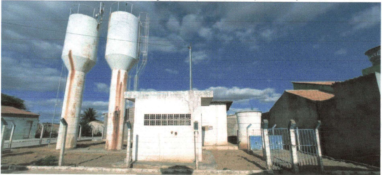
Figura 2. Sede de abastecimento de água do Povoado da Bonita, zona rural, Trindade – PE.
